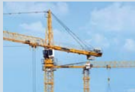
Grues à tour
